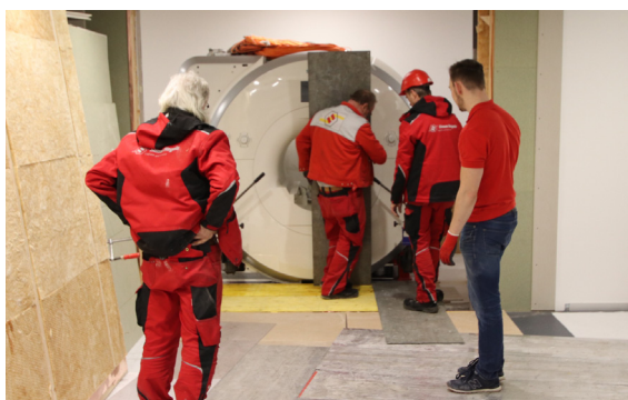
Aufwändig musste das MRI Tesla 1.5 mit einem grossen Mobilkran aus der Fensterfassade gehoben werden.
